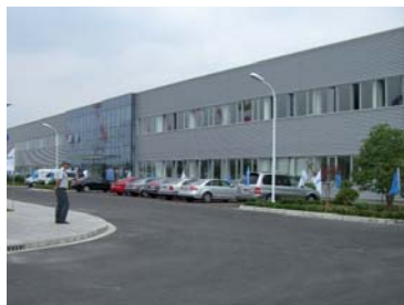
Neues Büro im Gewerbegebiet in Taicang
